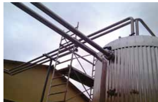
Raccordement ballon d'eau chaude
