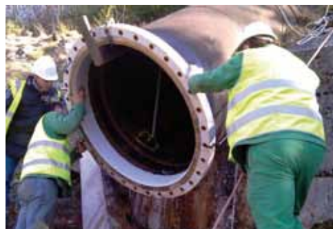
Soudure d'une bride sur conduite d'eau forcée (alimentation centrale hydroélectrique EDF)
