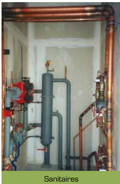
Raccordement ballon d'eau chaude
