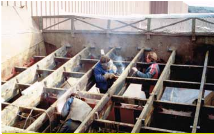
Remise en état d'un quai de réception sur unité de concassage
