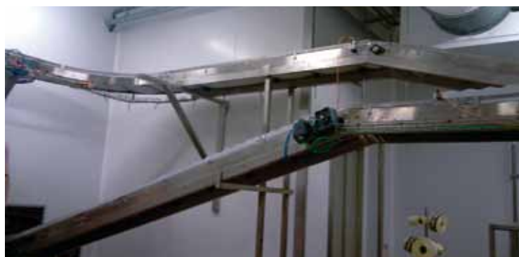
Remodelage d'un convoyeur existant
