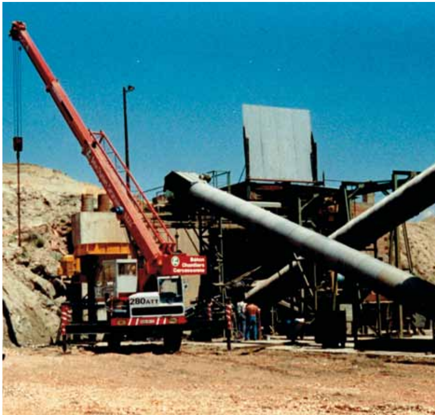
Manutention et mise en place matériel d'exploitation
