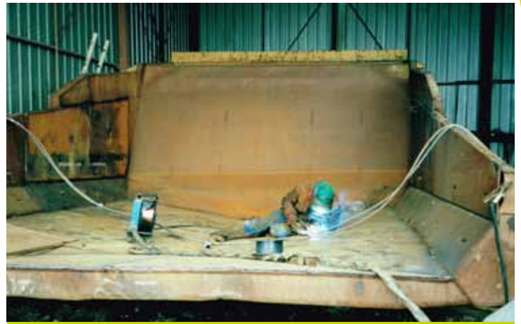
Réfection blindage inférieur benne Dumper
