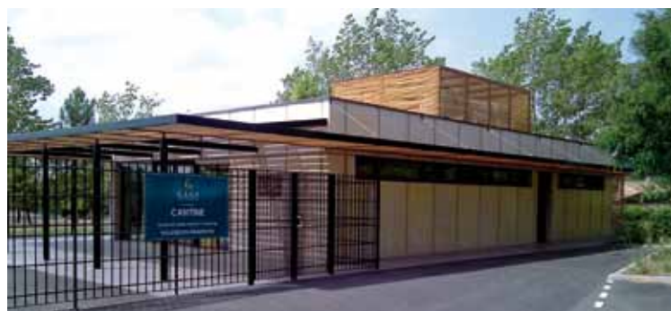
Brise soleil et clôtures d'une cantine scolaire
